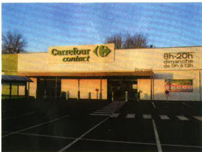
CARREFOUR Contact 10 Rue Dénoual 03.44.45.71.07
